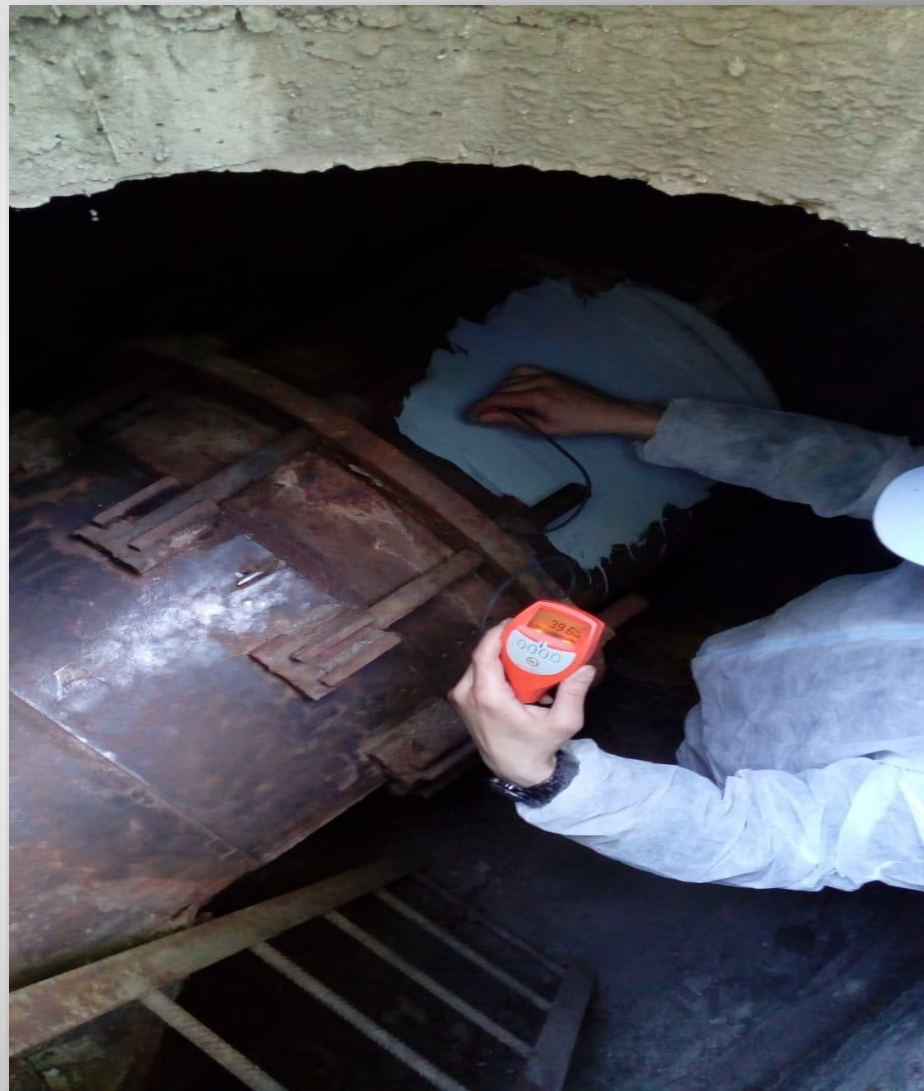
Магистральный трубопровод ГХВС
