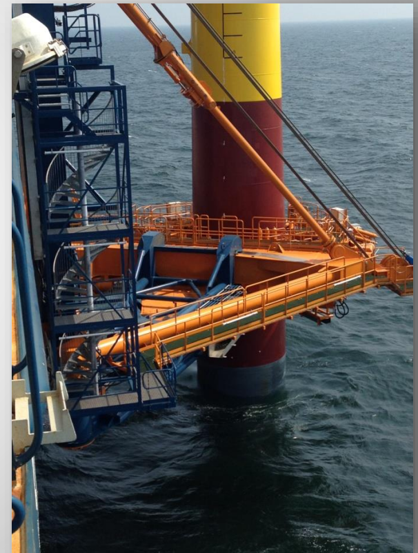
Свая ветрогенератора (Бельгия)
